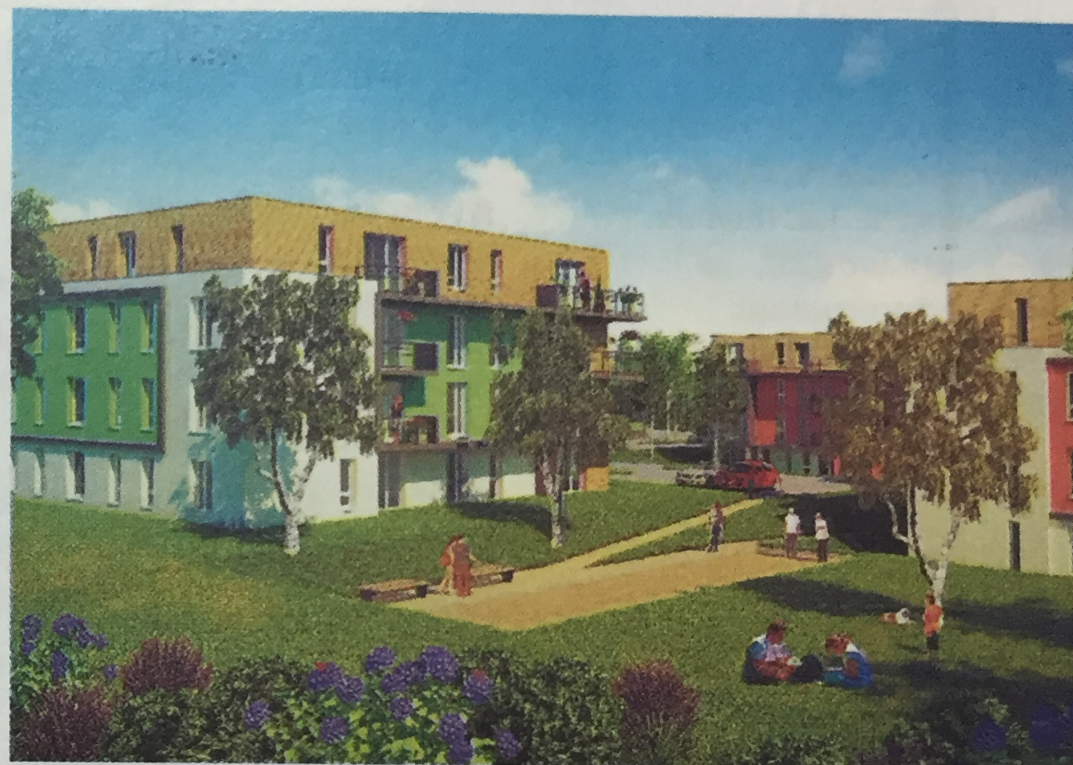
Novalys met en chantier 88 logements dont un individuel, certifiés Qualitel RT 2012- H&E Profil A, à Boves, Cabinet Leemann.
